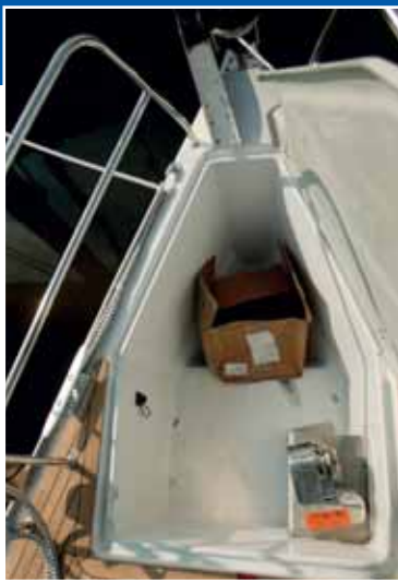
Het ankerbeslag loopt schuin naar bakboord weg. De ankerlier kan onderdeks geplaatst worden. De fundering van deze ankerlier lijkt niet in de mal voorbereid.
