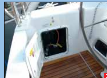
7 ▲ La bombona de gas queda alojada en un espacio en babor del puesto del patrón.
